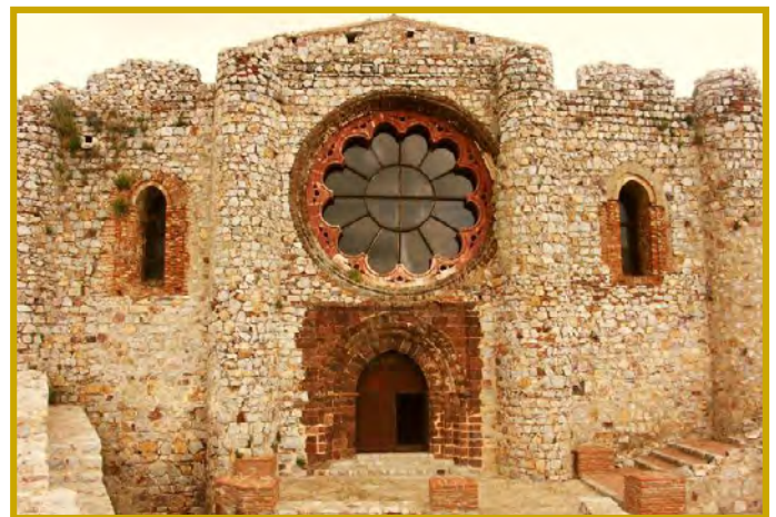
Puerta de la Estrella de la iglesia de Calatrava la Nueva
